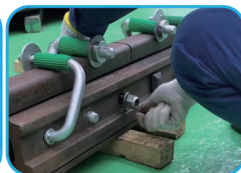
ボルトを締めれば完了
