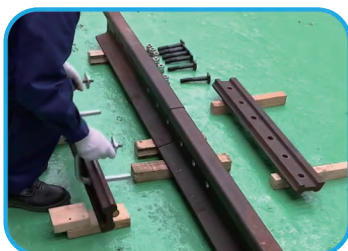
ネジ穴を利用して運搬
